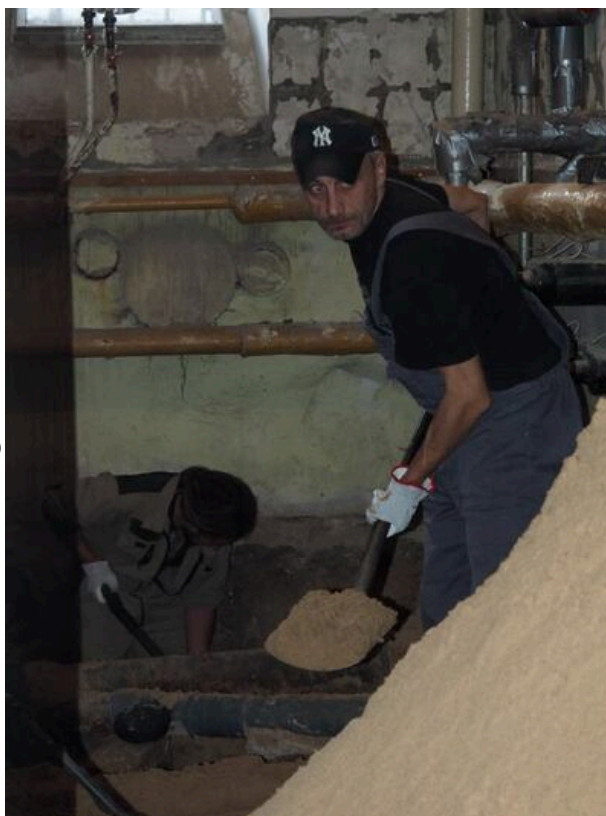
Prace ekshumacyjne w piwnicy budynku
