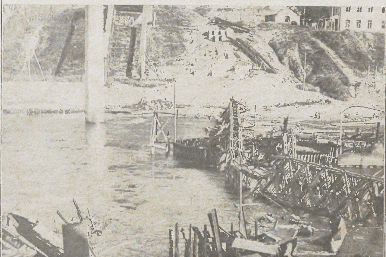
W ODZYSKANEM GRODNIE. ZNISZCZONY MOST PRZEZ NIEMEN W GRODNIE.
